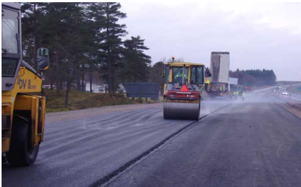
Bild nr. 2.6.2. Läggnig av AB- massa med utläggningsmaskin och vältar
